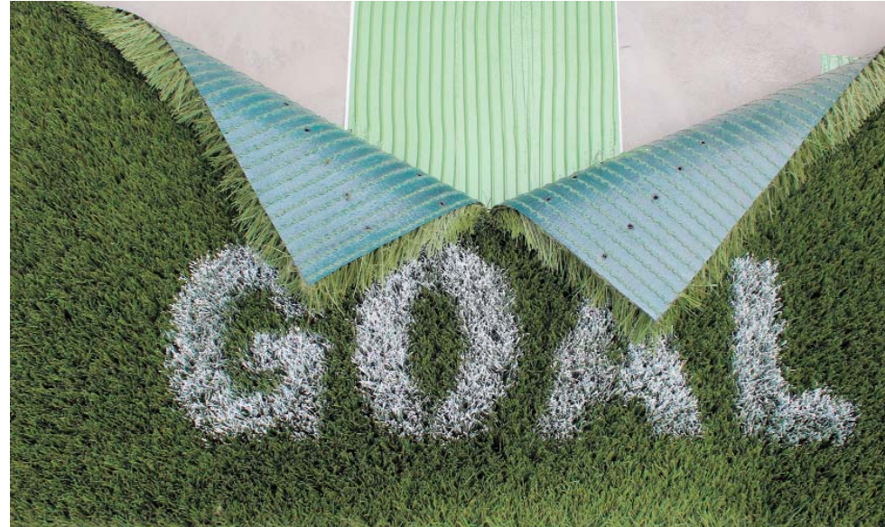
▼ Preparazione alla giunzione dei teli di erba sintetica
