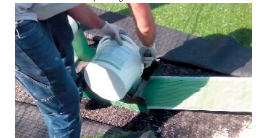
▼ Collante per la giunzione dei teli di erba sintetica
