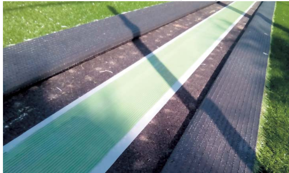
▼ Preparazione alla giunzione dei teli di erba sintetica
