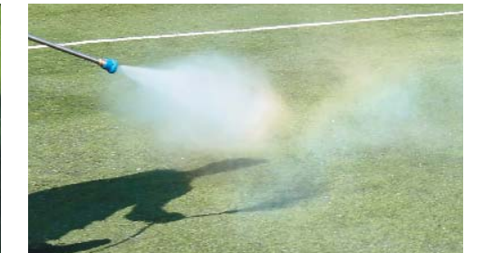
▼ Collante per la giunzione dei teli di erba sintetica
