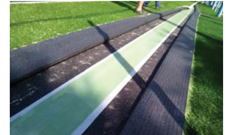
▼ Collante per la giunzione dei teli in erba sintetica
